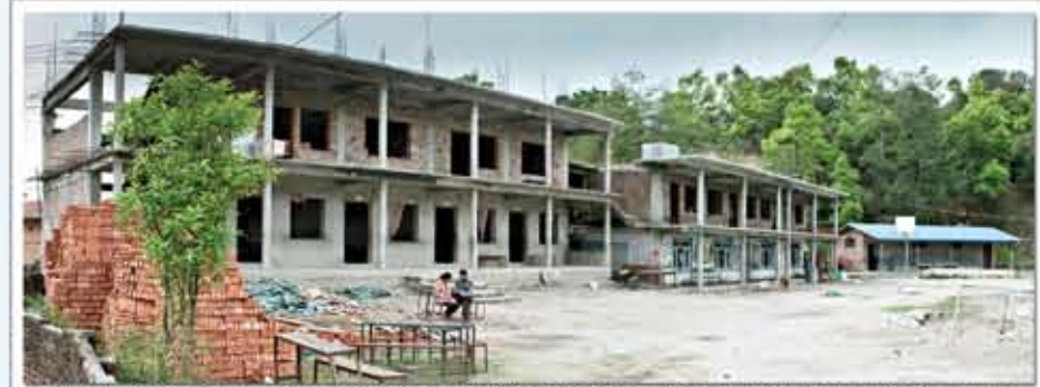
Die DORFSCHULE SALAMBUTAR wird stetig ausgebaut und verbessert. Die oberen Stockwerke sind jetzt fertig und es können über 500! Kinder unterrichtet werden.
